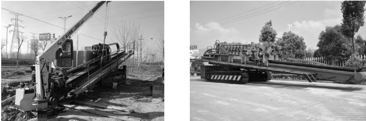
Рис. 2. Установки горизонтально-направленого буріння
