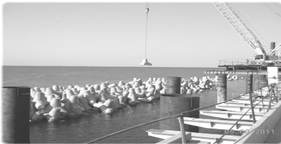
Рис. 6 - Огороджувальна споруда гравітаційного типу (з тетраподів)
